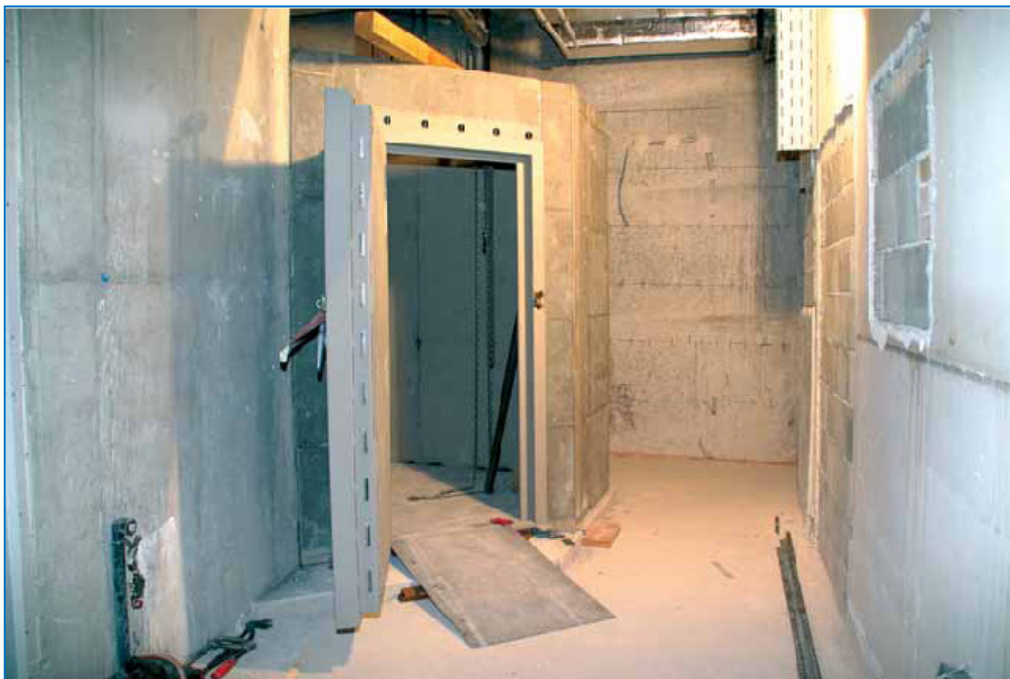
Elementi per la costruzione del caveaux prefabbricato mod. EET 070 con porta di sicurezza EWT 085
